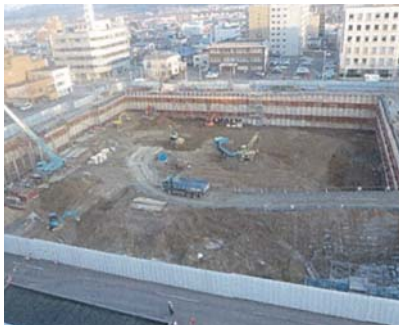
根切り工事の様子です。
