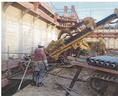
アースアンカー打設状況です。
