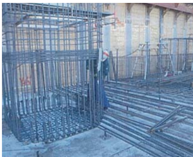
配筋工事状況です。
