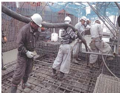
マットスラブコンクリート打設状況
