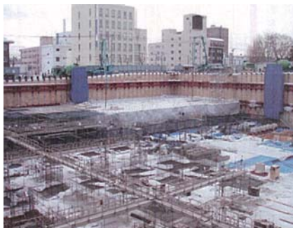
耐圧盤コンクリート打設状況他
