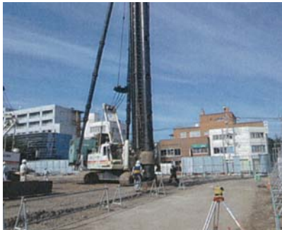
山止工事の様子です。
